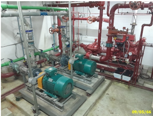
เครื่องปั้มน้ำใช้ และเครื่องสูบน้ำดับเพลิง
